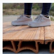
**4.** Oriente los huecos de Barro Kappa en el sentido de la pendiente de la losa para el libre flujo del agua de lluvia.
